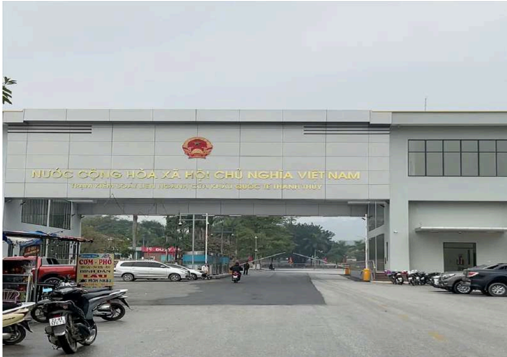
Hình 2.1. Trạm kiểm soát liên ngành cửa khẩu Quốc tế Thanh Thủy
